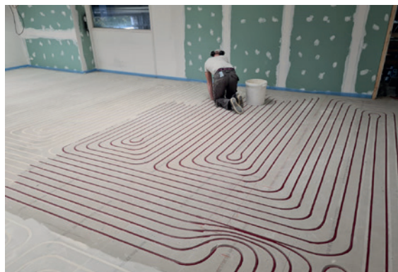
Montage buis met dichtsmen sleuven
