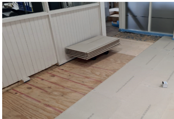
Knauf platen met houten ondervloer
